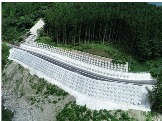
○優秀賞「夏：道路災害復旧 立ち並ぶアンカー」
