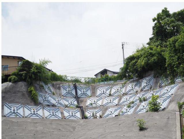
○入選「春：崩壊住宅地を守るアンカー」
