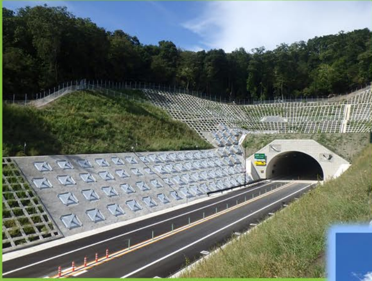
夏「アンカーと新設トンネル」 菅沼 優太
