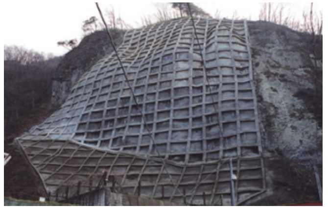
写真② のり枠工とグラウンドアンカー
