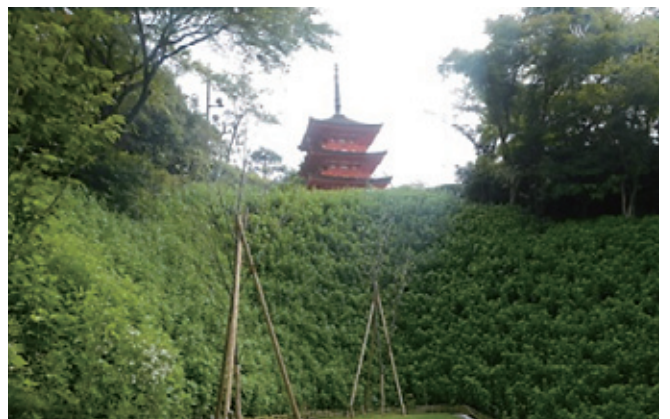
写真⑤ 施工完了後の子安塔（清水寺）斜面
