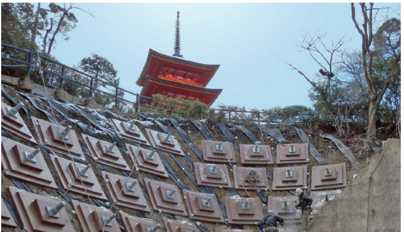
写真③ 子安塔（清水寺）の直下斜面にて施工されたグラウンドアンカー工法
